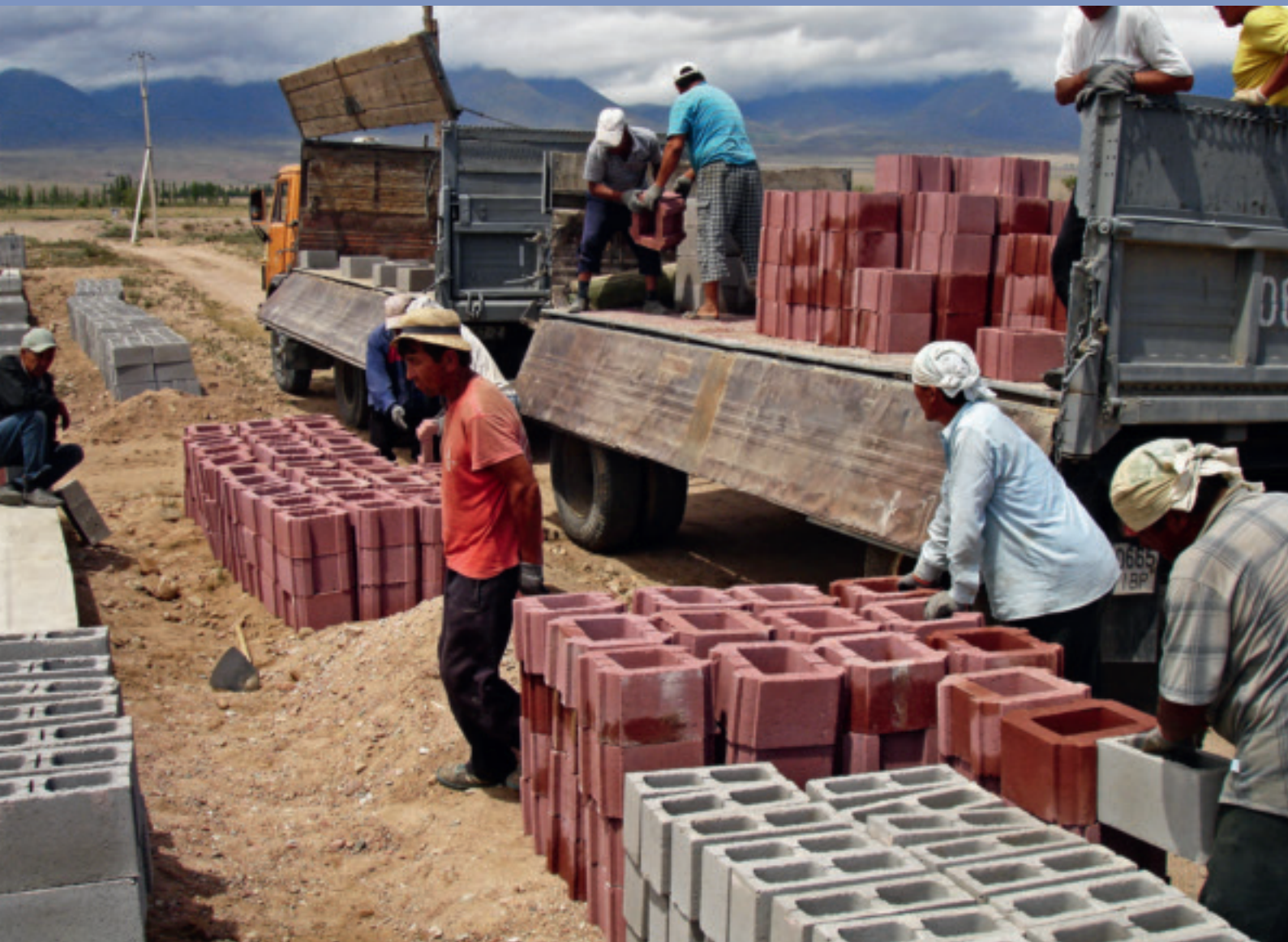
Byggingen av familiesenteret ved Issyk-Kul er i full gang. (Foto: Stefanusalliansen)
