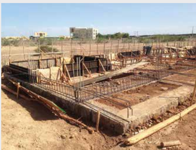
Et uferdig fundament vitner om byggestopp i Semera. (Foto: Paulus Shune)
