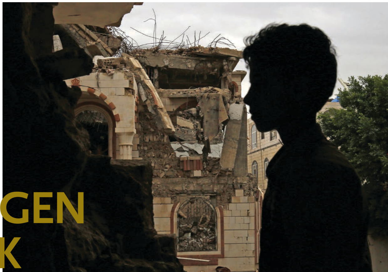
En jemenitt i Sana'a står ved en bygning som trolig ble skutt i fellebiter av et jagerfly fra Saudi-Arabia i juli 2019. Foto: Yahya Arhab/EPA/Scanpix
